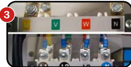
**FR :** Raccordez le réseau sur le bornier avant de l'inverseur de source. **Attention :** neutre à droite !
