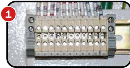
**FR :** Raccordez l'inverseur de source déporté au groupe électrogène
